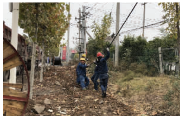
煤改电古城镇小集施工现场
