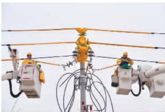
2月26日,原阳县供电公司组织带电作业人员,对平原示范区10千伏博凤线2号杆进行带负荷直线改耐张,并加装柱上开关,此次带电作业为河南省县级供电公司首次独立完成的配网不停电第四类工作。
