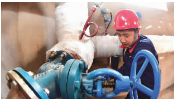
提升基础设施，保障供暖质量
