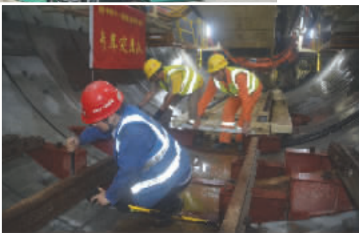
突击队员深入盾构施工一线铺设轨道
