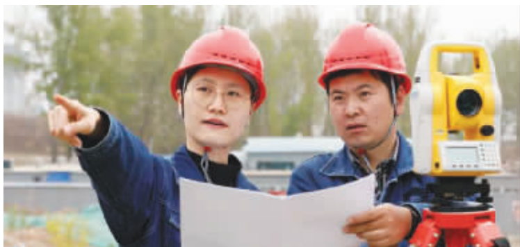
李菁菁在施工现场指导
